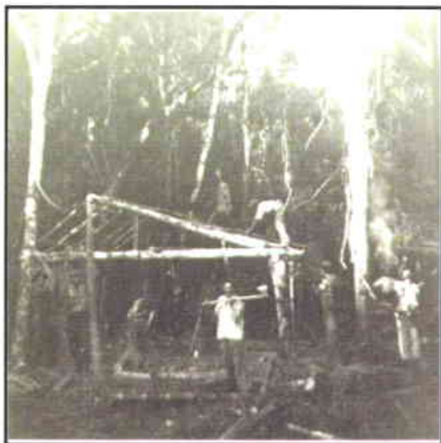
Figura 12 – Foto da construção das primeiras casas
