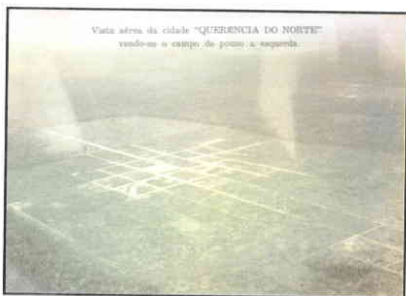
Vista aérea da cidade de Querência do Norte, destacando o corte das ruas e avenidas Fonte: acervo particular do Sr. Santo Borsatto.
