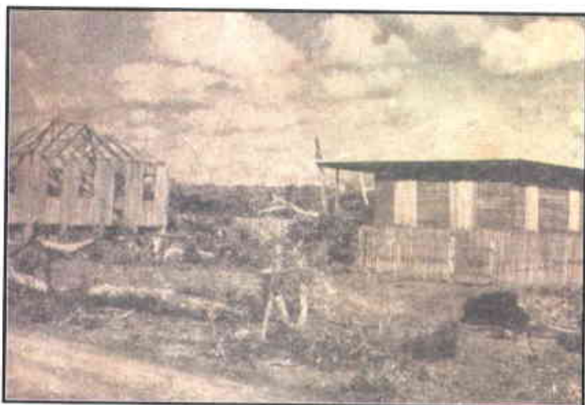
Construção de novas moradias
